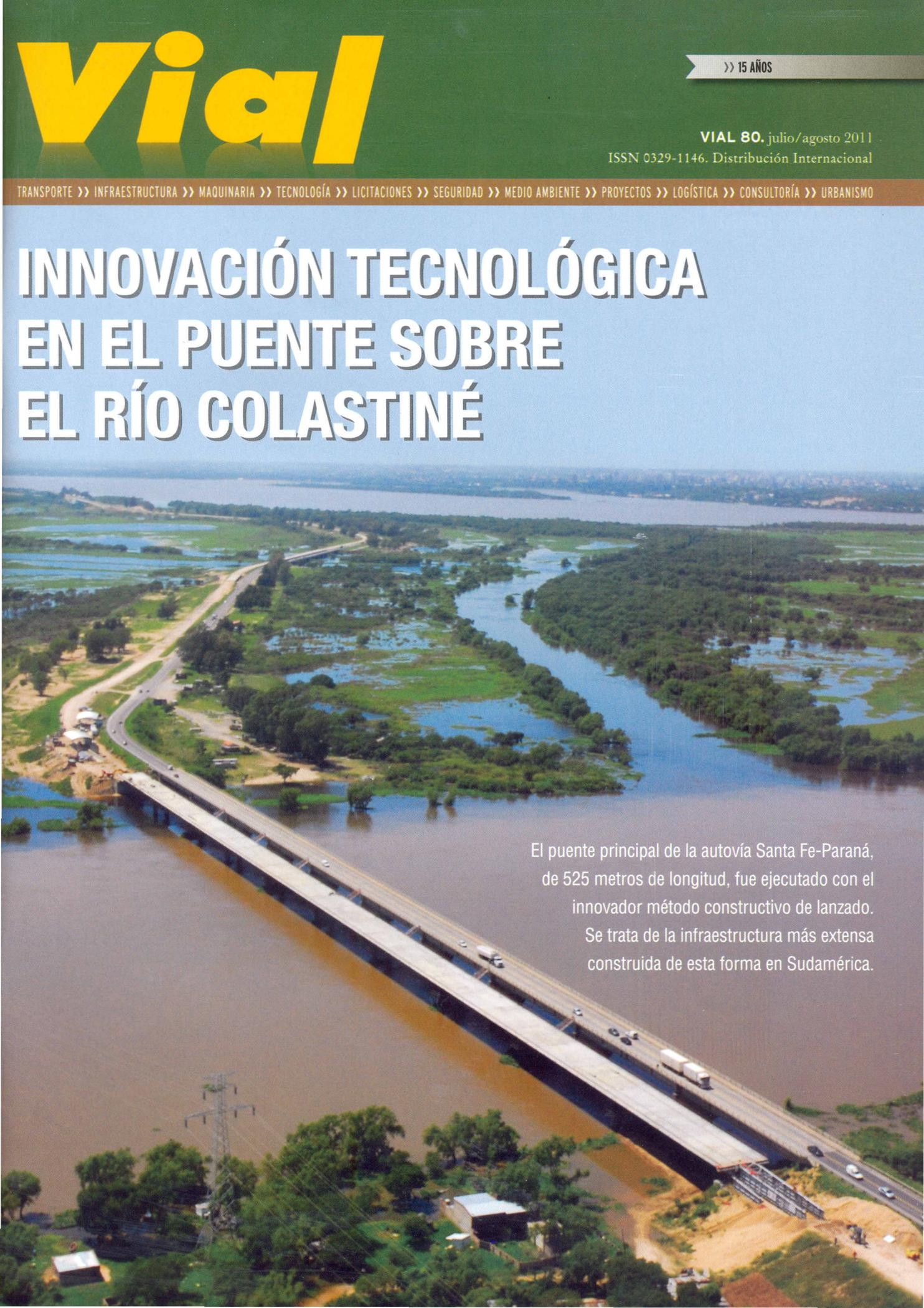
El puente principal de la autovía Santa Fe-Paraná, de 525 metros de longitud, fue ejecutado con el innovador método constructivo de lanzado. Se trata de la infraestructura más extensa construida de esta forma en Sudamérica.
