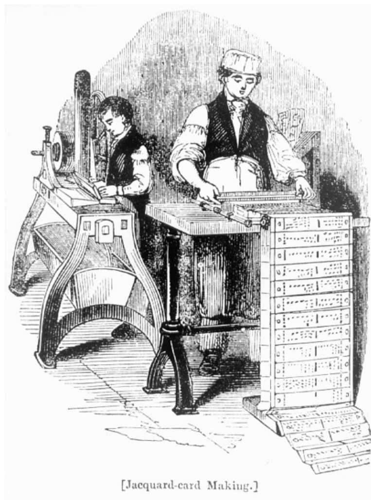
Figura 1.63 Preparando las tarjetas perforadas de un telar Jacquard
